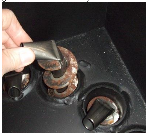
2. Drag upp turbulatorena ca 10 -15 cm och släpp ner. Upprepa ett par ggr.
