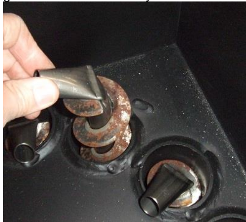
2. Drag upp turbulatorerna ca 10 -15 cm och släpp ner. Upprepa ett par ggr.
