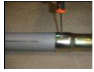
14. Fäst plaströret med medföljande skruv.
