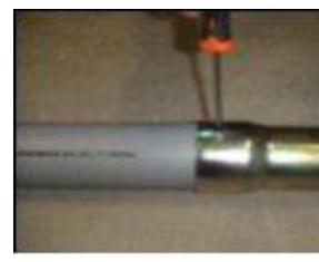
14. Fäst plaströret med medföljande skruv.
