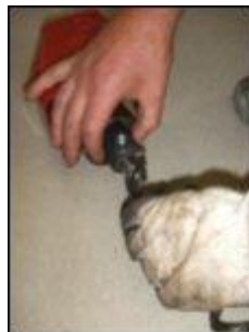
8. Gänga sedan tillbaka skruvspiralen slätt i bakkant på fästplåten.
